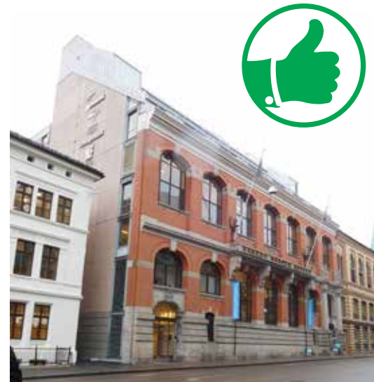
Etter en brann i Turnhallen i Oslo i 1988 ble det indre av bygget totalskadet, og et nytt bygg er gjenoppført bak den bevarte fasaden. Vellykket, mener Riksantikvaren. FOTO: RIKSANTIKVAREN
