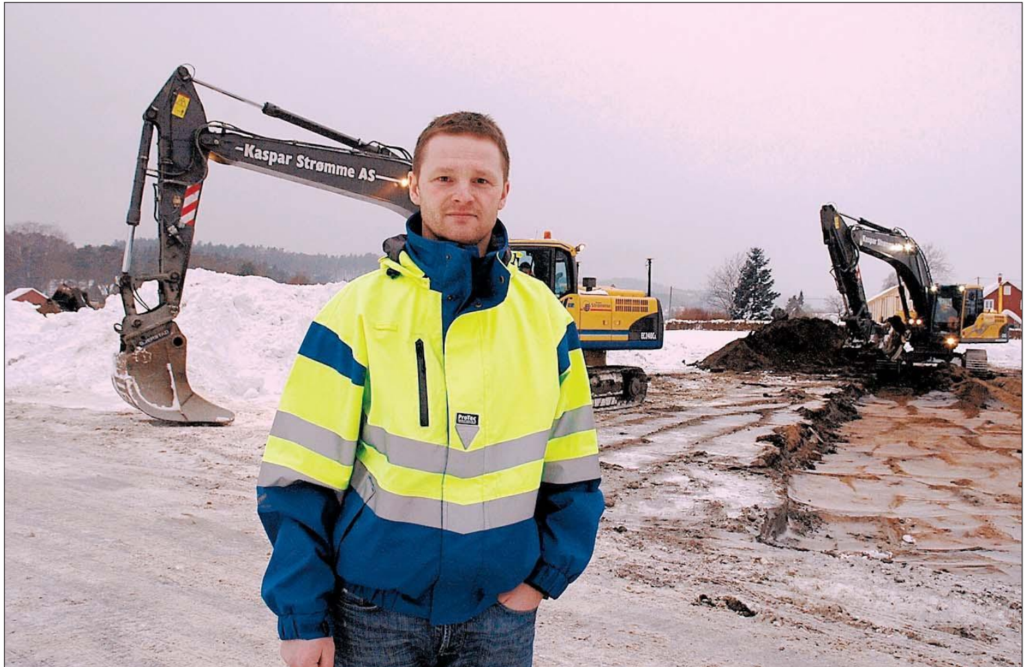
RIGGEOMRÅDE: Her på høyre side ved innkjøringen til Holta, blir det riggeområde for arbeidene med infrastrukturen i området rundt den nye ungdomsskolen, kan Steinar Ånesland i Lillesand kommune fortelle.
