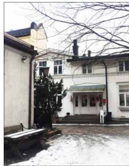
Tre- og murhus i en skjønn forening. «Styrtebad Karlsro» holdt til i murhuset til venstre. FOTO: STEIN ERIK KIRKEBØEN
