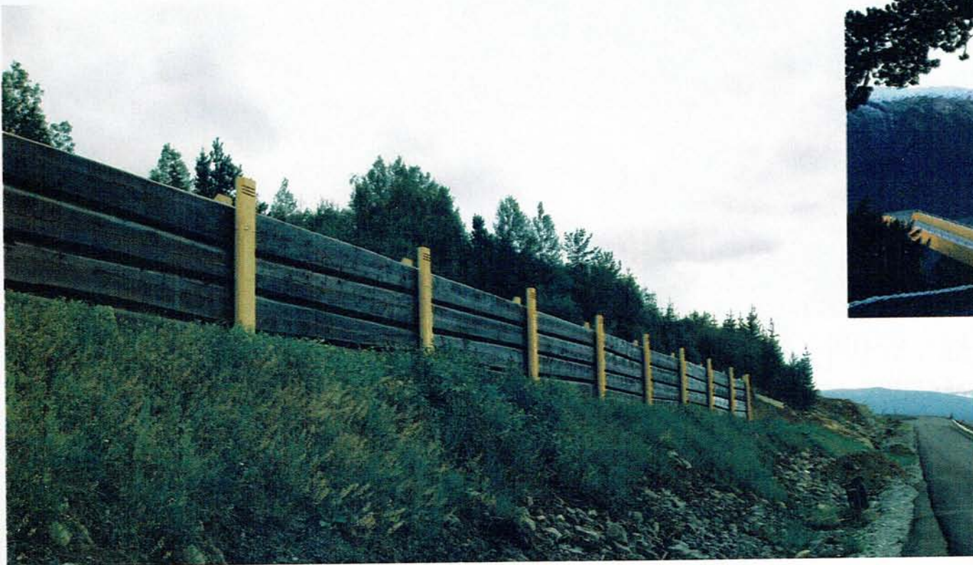
Laftet tømmer inngår i denne støyskjer- men bygget av Statens vegvesen
