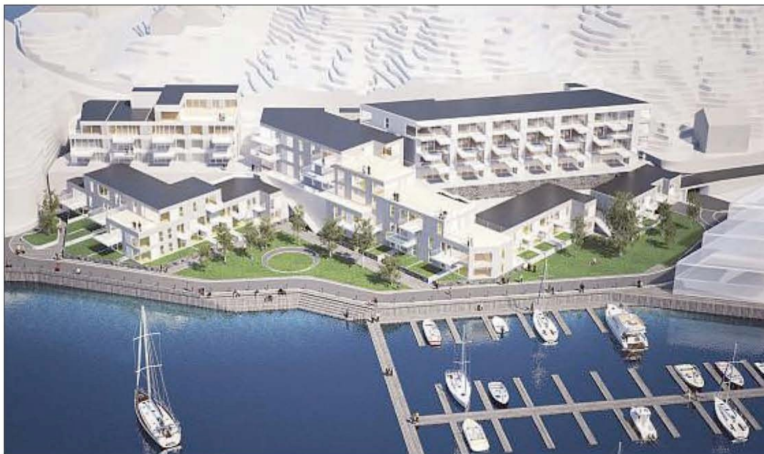
Nylig ble det solgt en leilighet i Flisvika til en pris av 5,6 millioner. I dag er det duket for ny presentasjon av Flisvikaprojektet.
