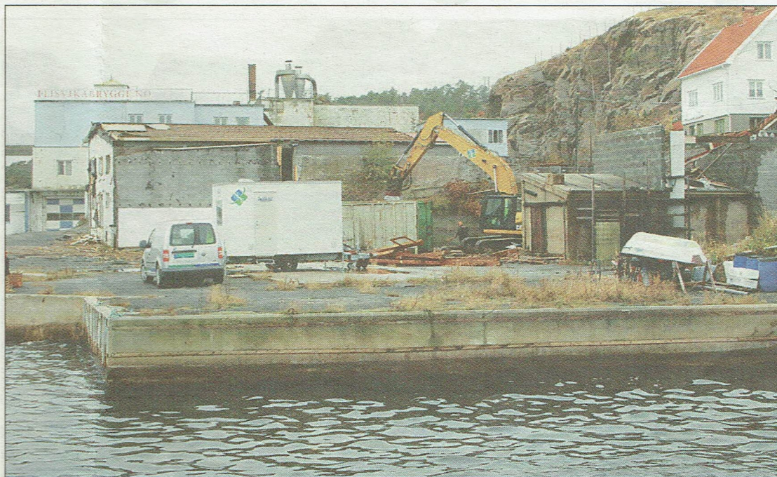
Rivningsarbeidene i Flisvika pågår fortsatt.
