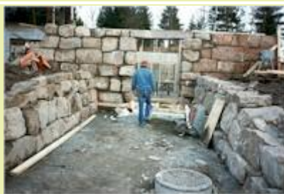
Det av grunnmuren som kunne gjenbrukes
